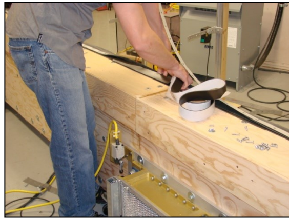
(d) Air sealing the pressure plane
