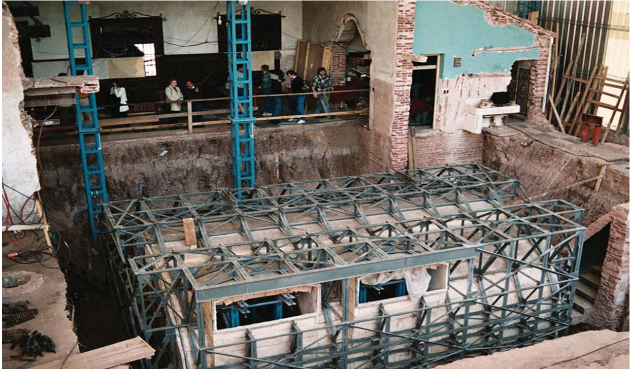
Fig.20 Fotografía tomada luego de la demolición de gran parte de la casa y preparación de la estructura que sostuvo toda la pieza. Schávelzon, Daniel. “La historia de un mural: Siqueiros en Argentina.”2013. JPEG file.
