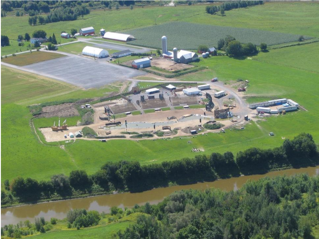
Vue aérienne du site de la Ferme Drouin, 2004-2008
