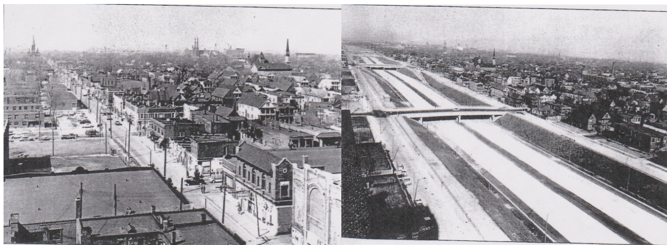
Figure 28 - Vue avant/après de l'autoroute Hasting Street
