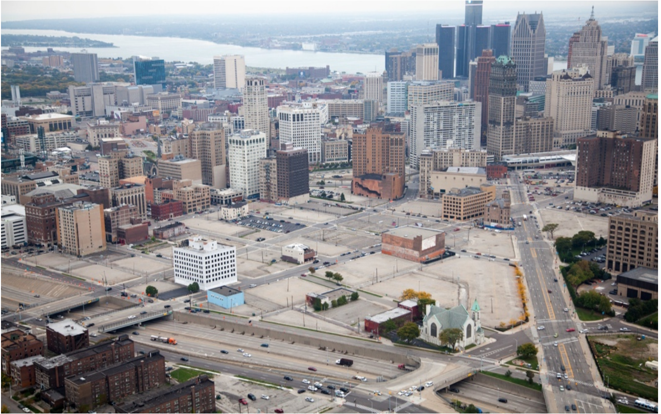
Figure 23 - Vue aérienne du centre-ville de Détroit
