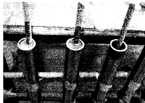
(g) Pouring of Grout
