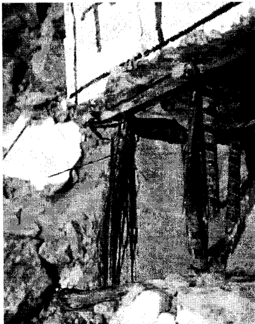
(d) Tension Rupturing of Bars
