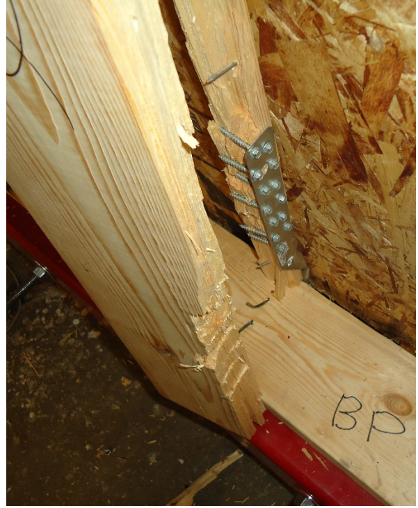
b) Stud 2 Splitting failure
