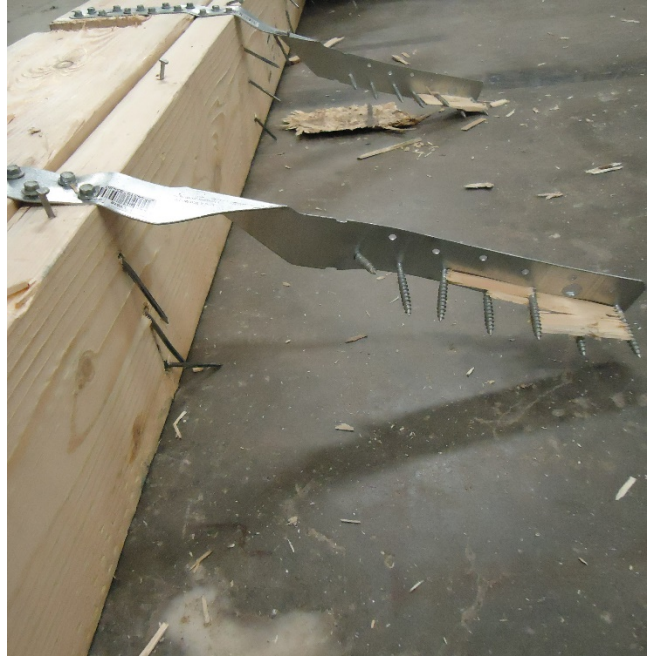
b) Stud 5 Splitting failure
