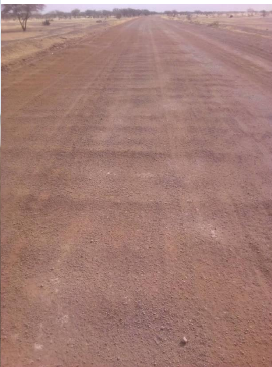
Annexe n°7 – Photos de l'état dégradé de la route et de la poussière dégagée par la circulation sur la principale voie de communication reliant Falagountou et la province de l'Oudalan.
