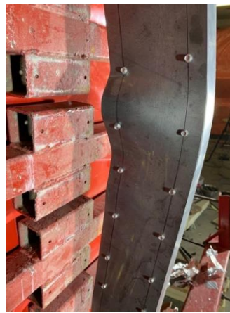
(d) Mullion 2H after test
