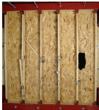
(d) Sheathing damage
