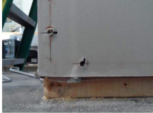
b) Edge Pull-Through at Bottom Edge (Wall-3-1)
