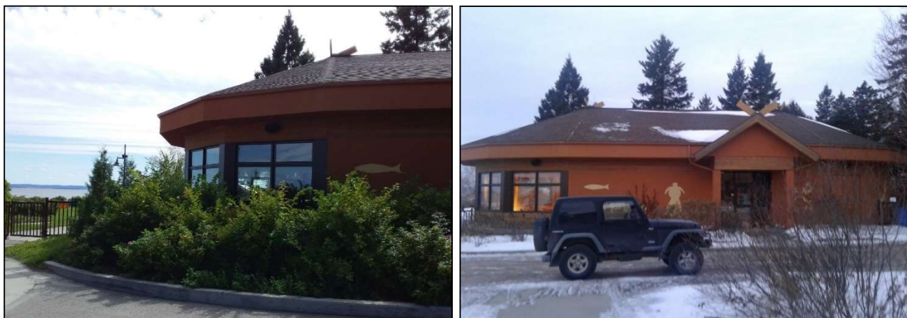
Le kiosque culturel vu de la porte arrière du carrefour d'accueil (2018, 2017)
