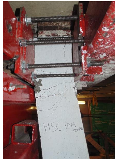
f) Top hinge at blast 4
