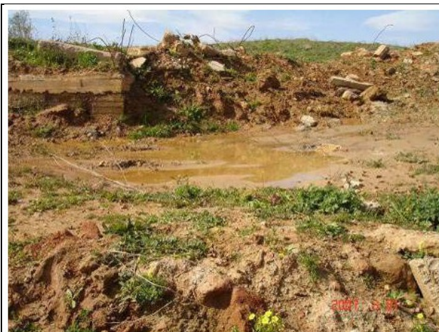
Stagnation des eaux en amont dans des fondations abandonnées par l'Homme
