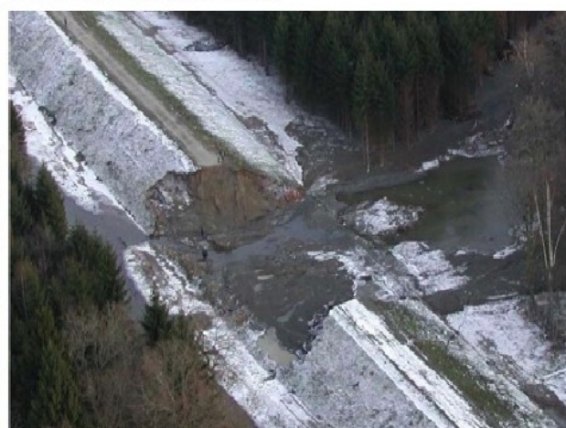
Rupture de digue de protection non surveillée
