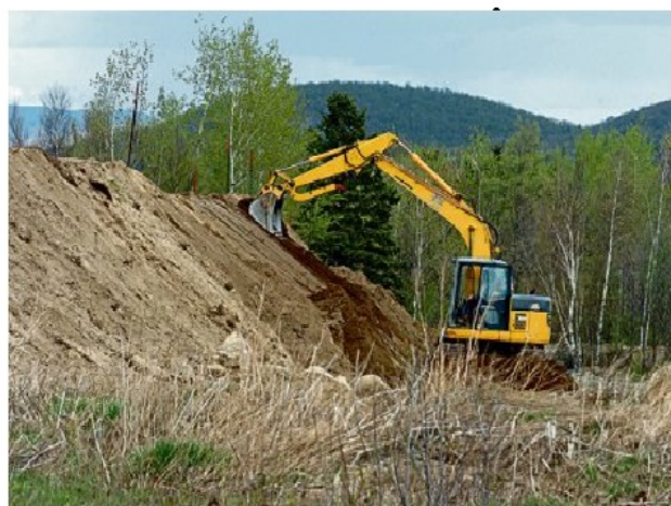
L'excavation d'une carrière
