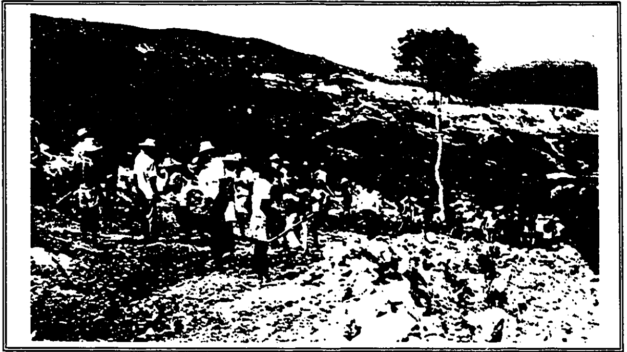
fig. 4: Une journée de travail lors de la construction de la route Tapion-Vallée
