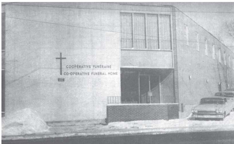
Figure 3.2 – La Coopérative funéraire (1963) visée par la démolition. Source: APJLL.
