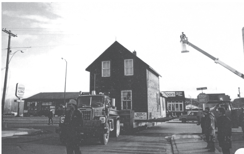
Figure 3.13 – Maison patrimoniale (1903) relocalisée pour devenir le Musée du Moulin-à Fleur, rue Wilma (décembre 1987).
