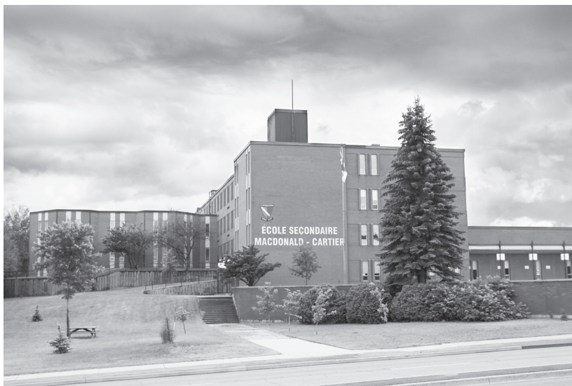
Figure 3.4 – L'école secondaire Macdonald-Cartier (1969).
