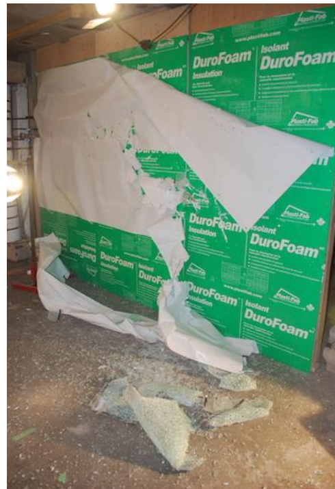
(d) Damaged witness panel after Test C4
