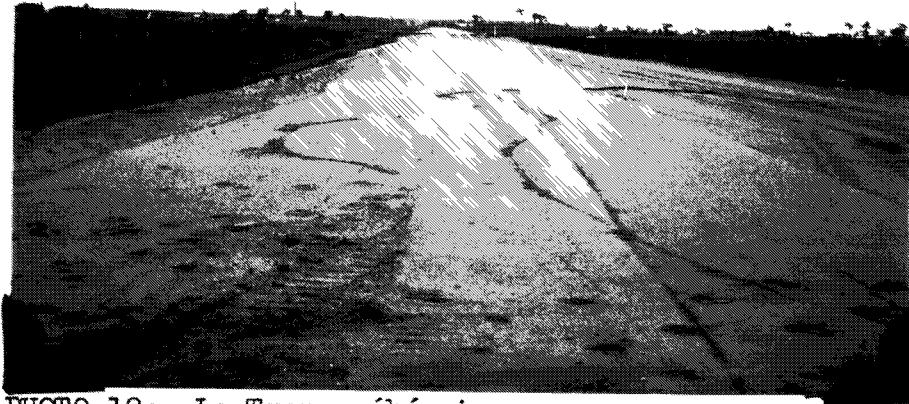
PHOTO 12: La Transquébécoise. Tronçon de la Transquébécoise en construction près du village de Larochelle qui rejoindra éventuellement la Transcanadienne.
