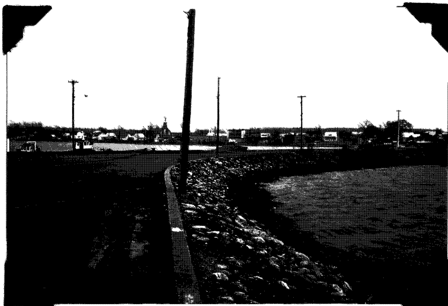
PHOTO 5: Le quai du Service de la Traverse. Pour assurer une certaine profondeur au quai, il fut nécessaire de construire une jetée d'une longueur de deux arpents environ du village de Laval, que l'on aperçoit à l'arrière-plan.
