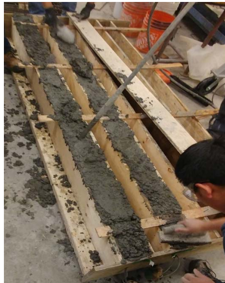
(d) Casting of the beams with vibration
