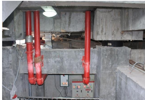
(d) Pipeline at the Isolation Interface
