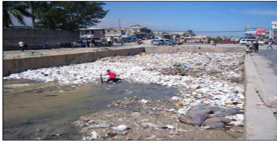
Figure 1 - Canal d'irrigation obstrué
