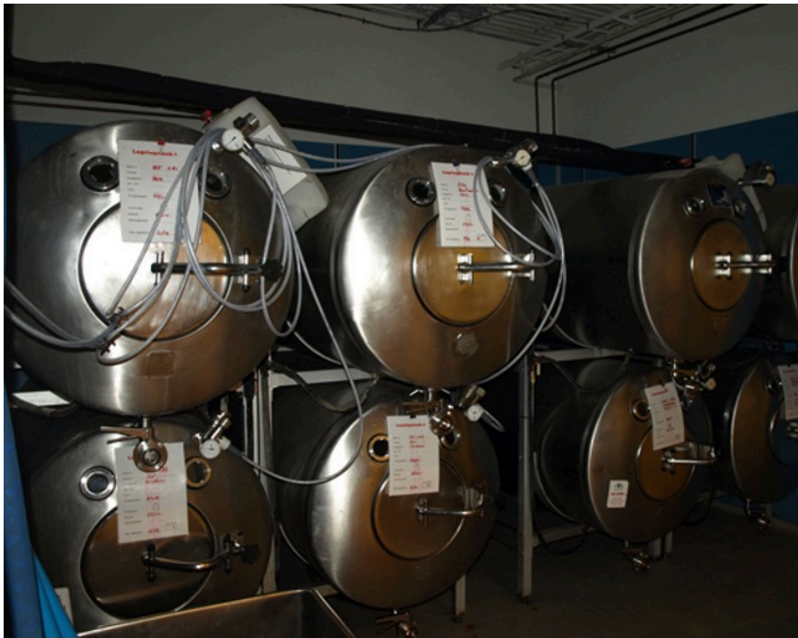
Figure 7.17 La fermentation du jus de raisin en vin produit le \text{CO}_2 comme produit secondaire. Des réservoirs à fermentation possèdent des valves afin que la pression dedans les réservoirs créer par le dioxyde de carbone peut être libéré.
