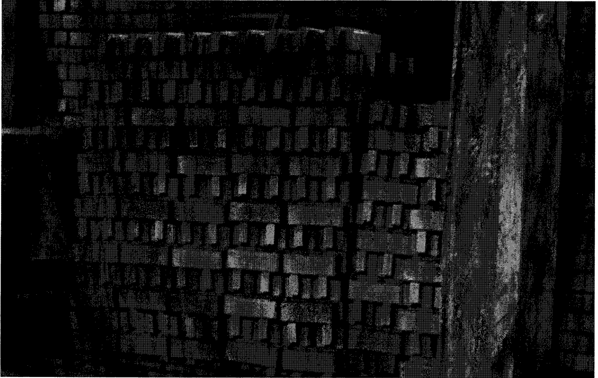
Le chantier de brique pour le projet habitat de la CECREAM, Goma RDC
