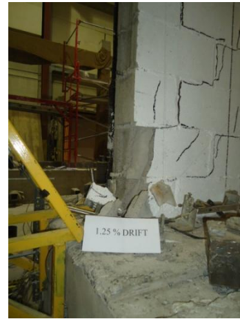
(d) East corner crushing; 1.25% drift
