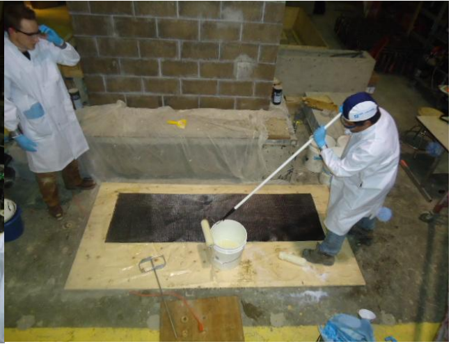
(d) Saturation of FRP sheet with epoxy
