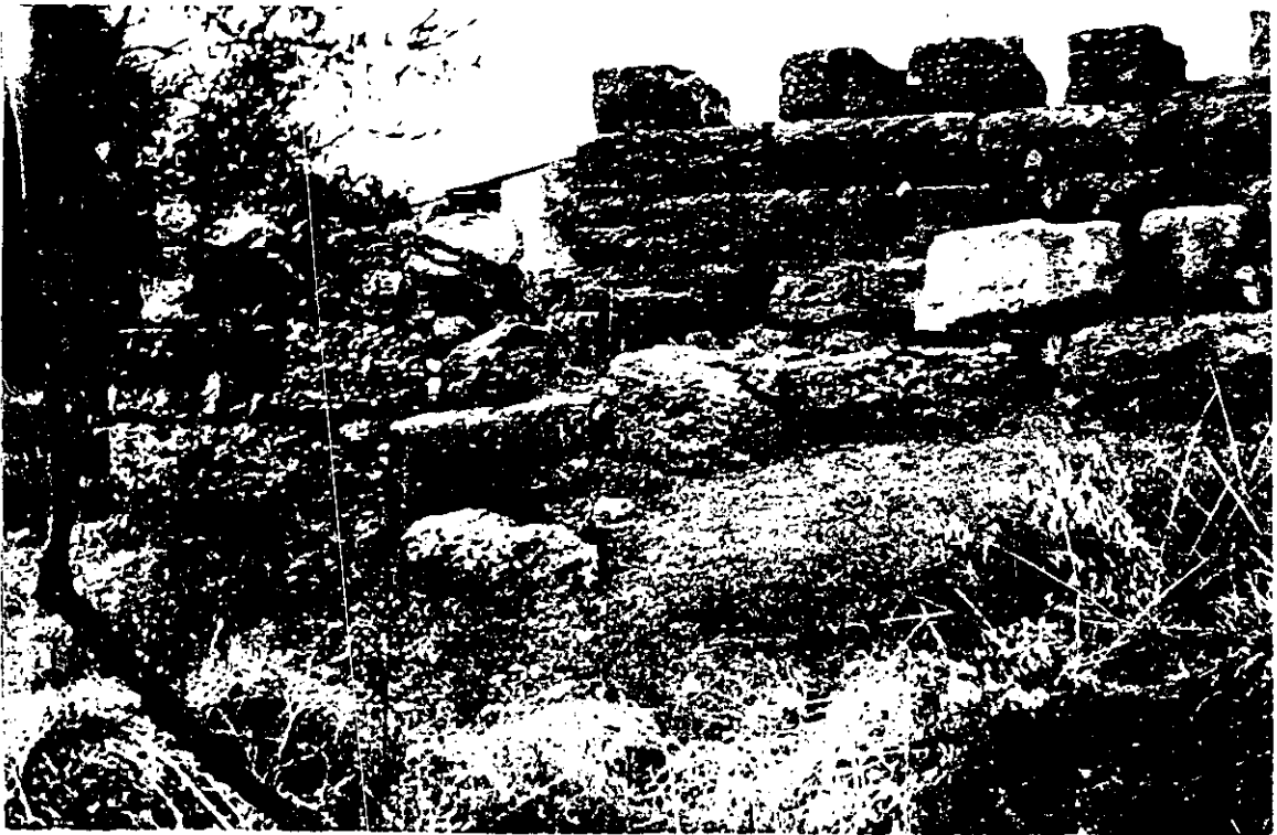
photo 31 Pagai. Mur au Nord de la tour Nord-Est. (MAB)
