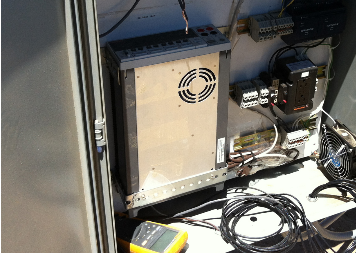
FIGURE 3.11 – L'unité de source et mesures du site de tests de Mojave au cours de l'installation du système en mai 2013. L'instrument mesure la courbe I - V des cellules photovoltaïques du panneau prototype [13].
