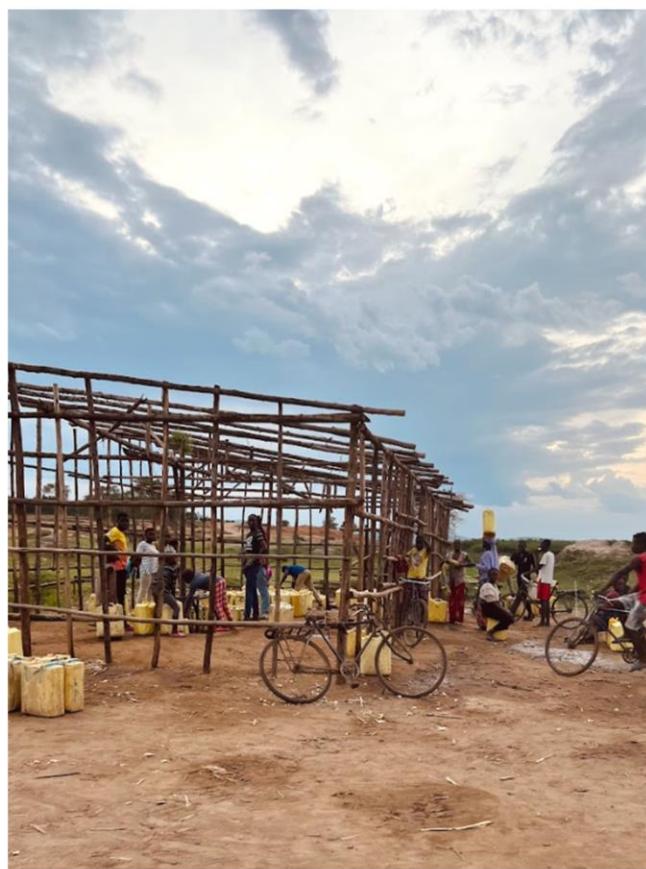
La photo ci-dessus montre la pompe du puit d'Aron et le restaurant de Kennedy sur la gauche.
